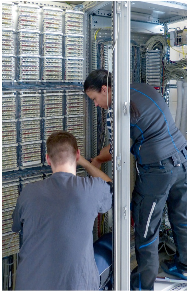
Umbauarbeiten durch SAE-Mitarbeiter
